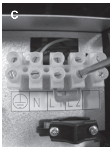
Рисунок 10 С и D. 1-фазное соединение каменки
